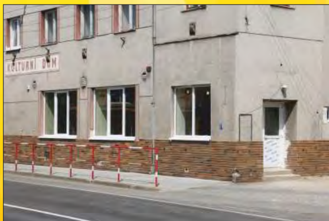
Výměna oken a dveří v objektu bývalého kina
