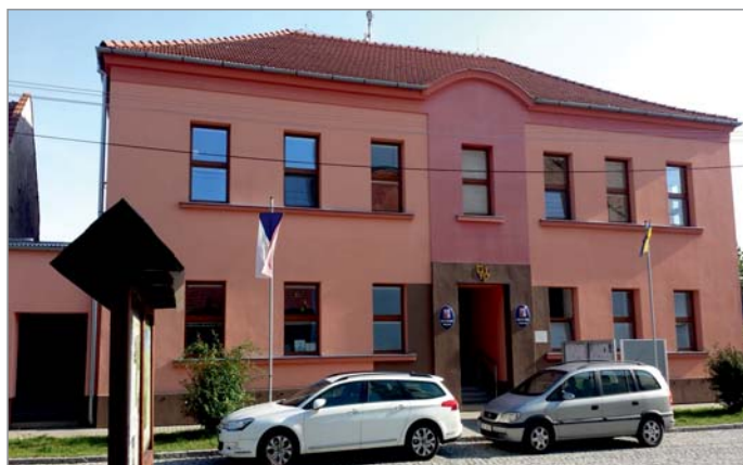
Obecní úřad a mateřská škola
